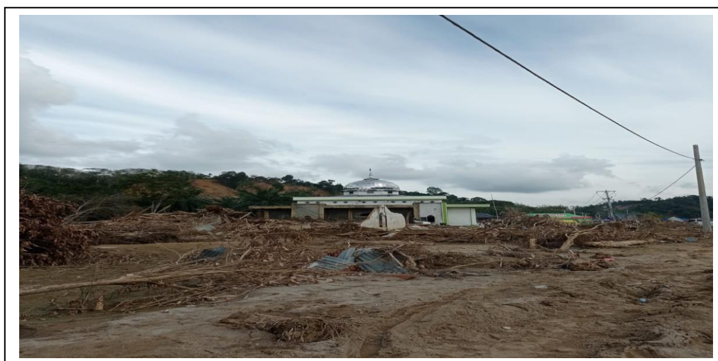
Gambar 1. Bangunan masjid di desa Lubuk Sidup pasca banjir bandang
